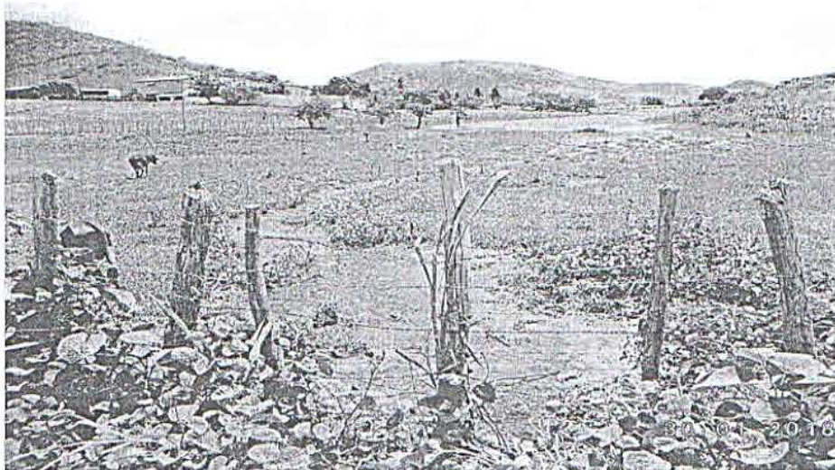
Figura 6 – Vista do canal que leva a água da infiltração da barragem auxiliar passando pela manilha para a barragem vertedoura existente (Data da imagem: 30/01/2018)
