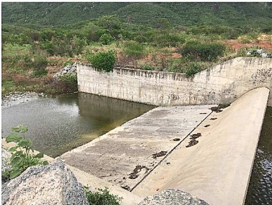
Figura 16 – Vista do vertedouro – Creager, muros laterais, rápido e bacia do canal de restituição (Data da imagem: 30/01/2018)
