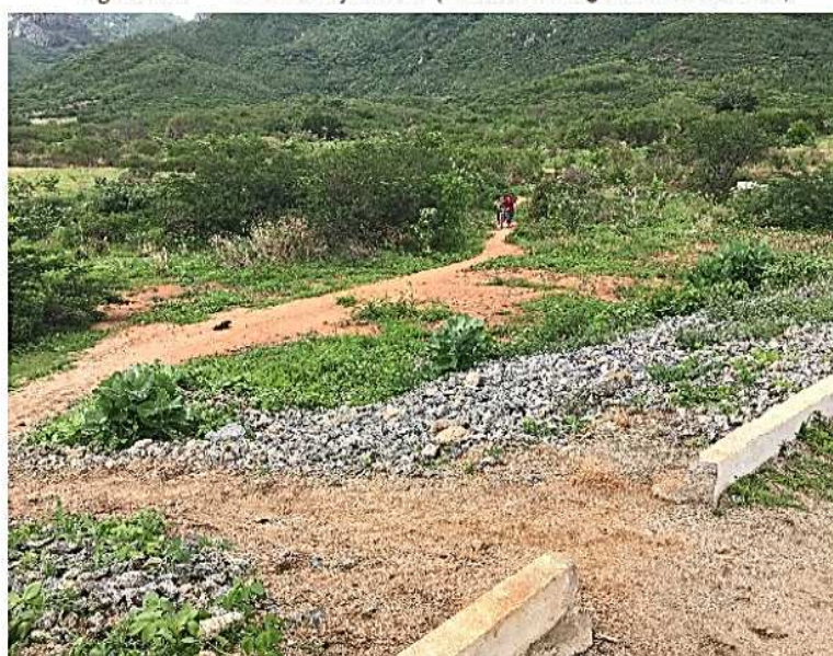
Figura 14 – Acesso de pedestres no talude de jusante (Data da imagem: 30/01/2018)
