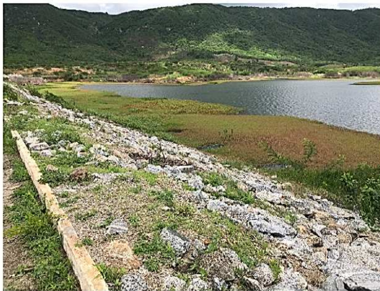
Figura 12 – Talude de montante (Data da imagem: 30/01/2018)
