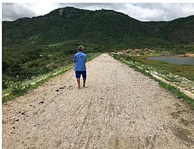
Figura 11 – Coroamento da barragem (Data da imagem: 30/01/2018)
