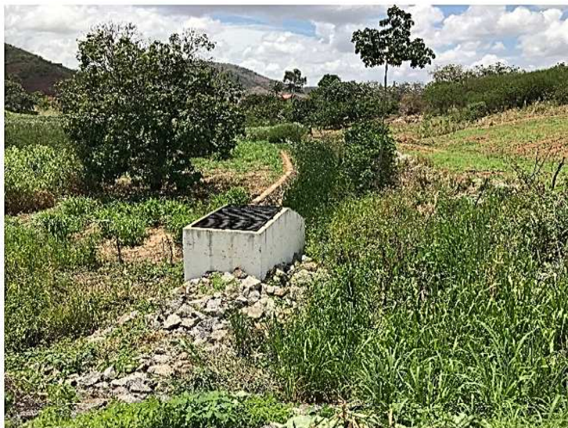
Figura 10 – Tomada d'água (Data da imagem: 30/01/2018)
