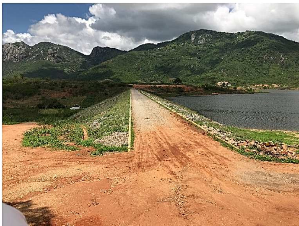
Figura 4 – Vista da barragem auxiliar (Data da imagem: 30/01/2018)
