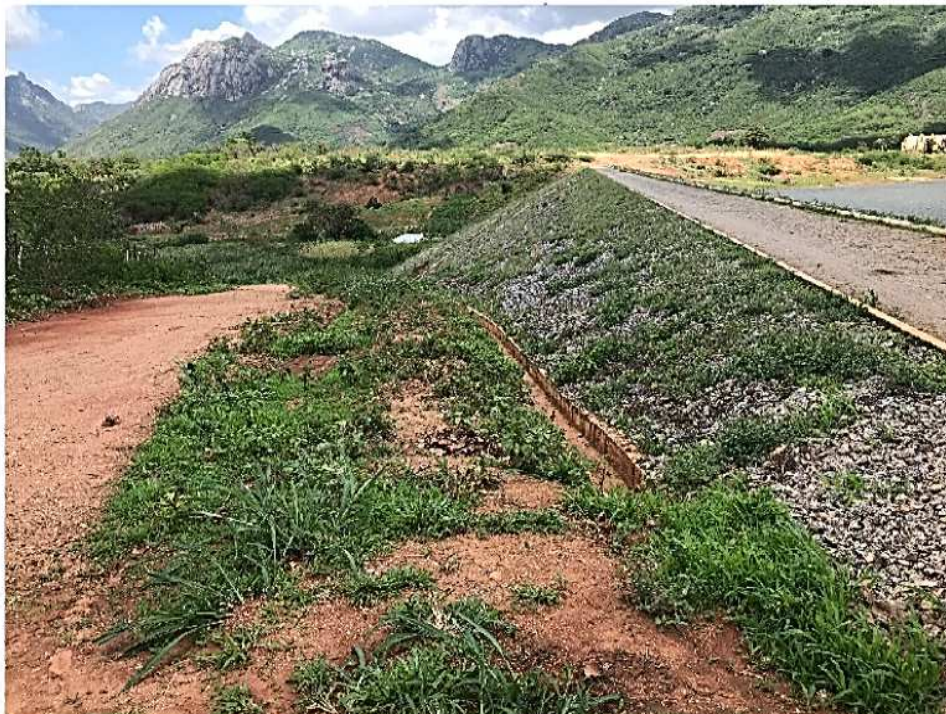
Figura 7 – Vista do talude de jusante da barragem auxiliar (Data da imagem: 30/01/2018)
