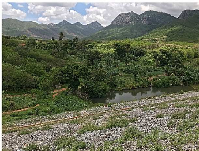
Figura 13 – Talude de jusante (Data da imagem: 30/01/2018)
