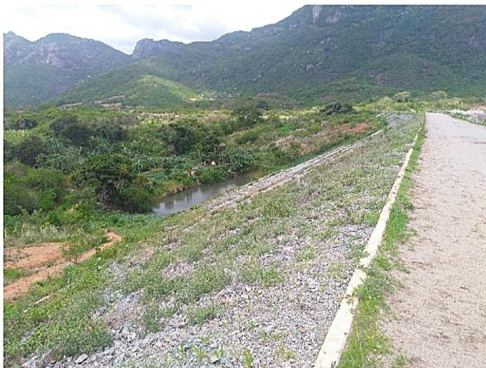
Figura 3 – Vista da barragem principal (Data da imagem: 30/01/2018)
