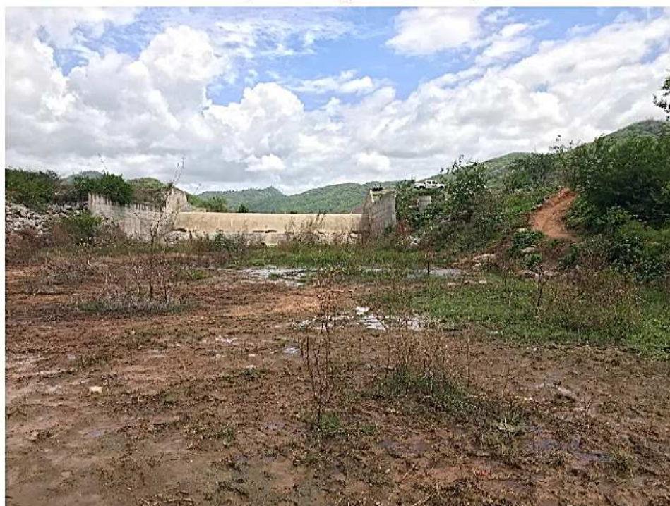
Figura 17 – Vista frontal do vertedouro (Data da imagem: 30/01/2018)
