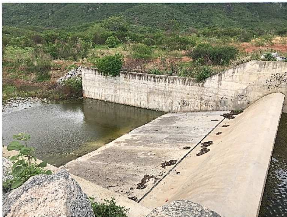
Figura 5 – Vista do vertedouro (Data da imagem: 30/01/2018)
